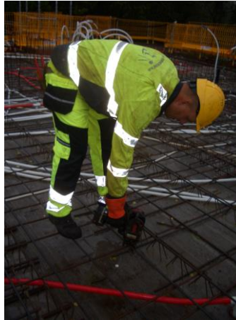
Jernbinding av gulv, bilde 4
