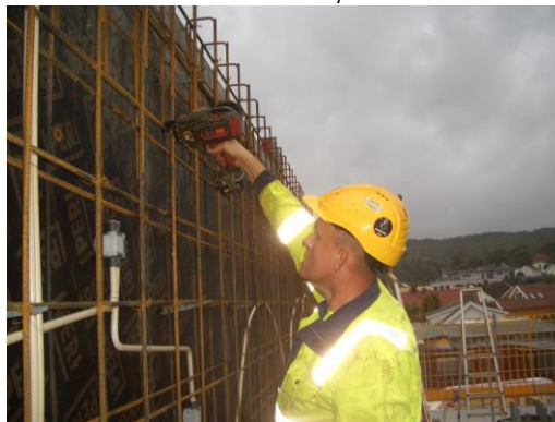
Bruk av bindemaskin, bilde 2.
