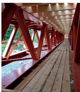
Kryssavstivning Enkel kryssavstivning med vinkelstål.
