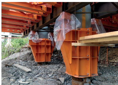
Søylebrakett Lastoverførsel til søyler uten bruk av midlertidige fundamenter.
