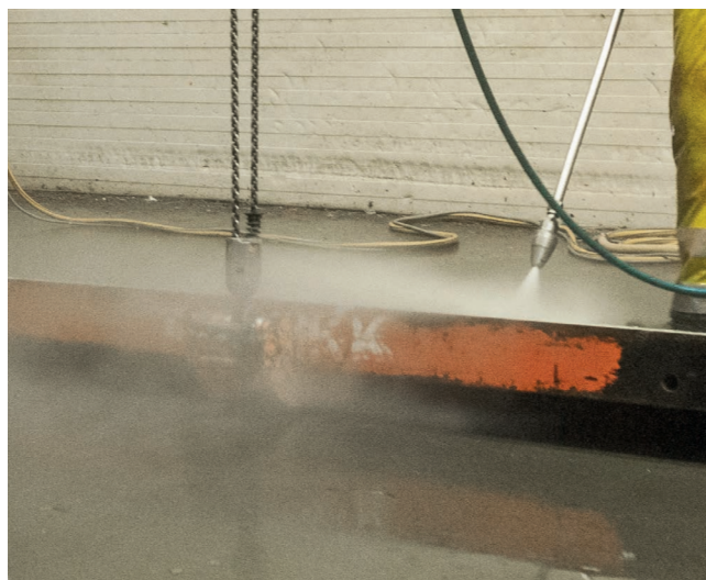
Dekket av RentalPlus: Endelig rengjøring og balsamering av overflater.
