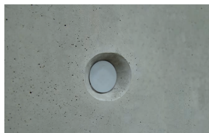
3. Nå er staghullet tettet og det trengs ingen ytterligere etterbehandling
