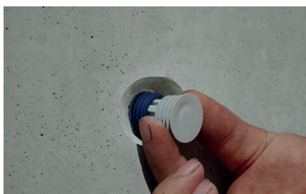
1. Etter riving av forskaling, fjernes konus, og staghullet tettes med svelleplugg
