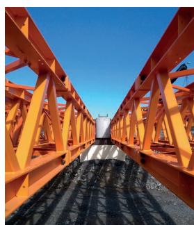
Fagverksdrager Effektivt fagverk med lav byggehøyde.
