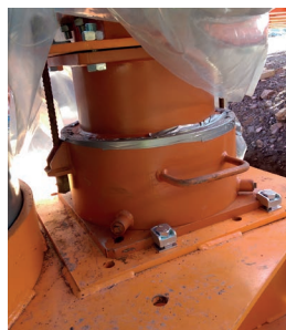
Sandsenk Enkel senk av fagverket etter støp.
